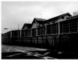
Noise barrier (周辺住民の住環境保護)
