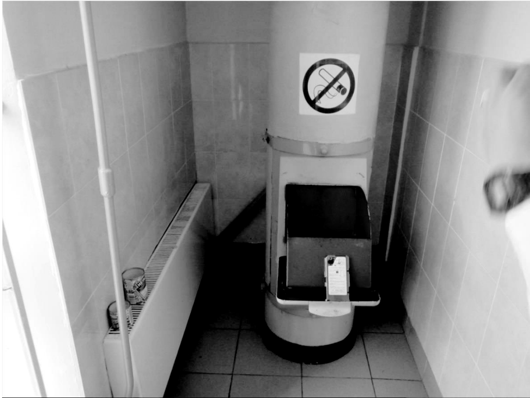
図 2-11 集合住宅内（5階）家庭廃棄物用ダクト入口
