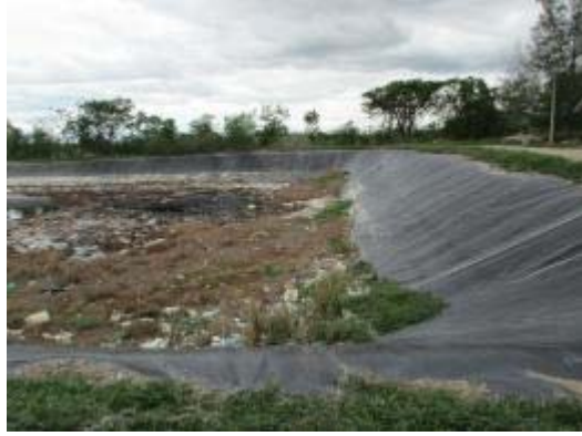
新しく整備済みの第二埋立地。防水シートが敷かれている。
