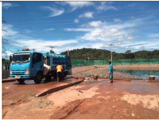
洗車場と隣接した水処理場
