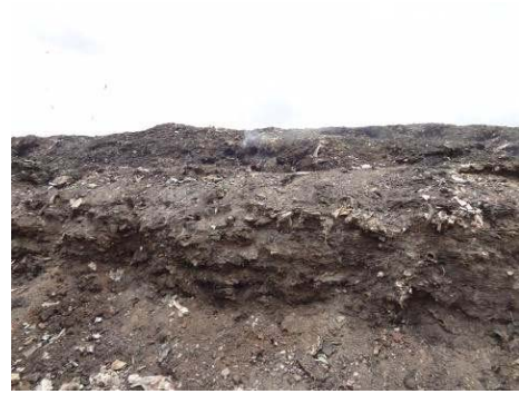
処分場（煙視認）
