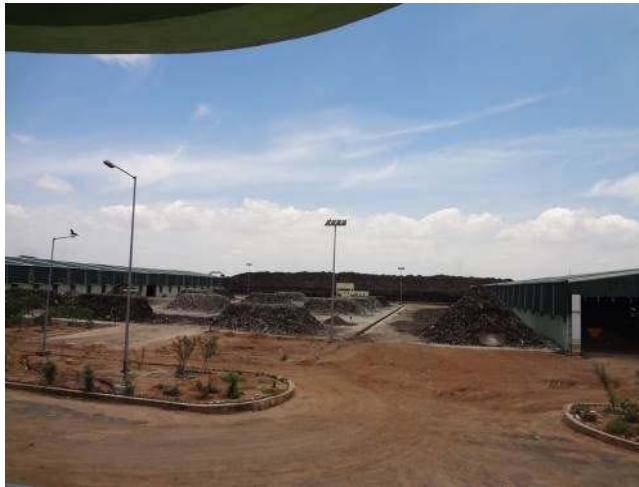
写真 コンポストヤード全景（ダンプ サイト内） （写真中央は発酵中の廃棄物、写真奥はダンプ サイト）
