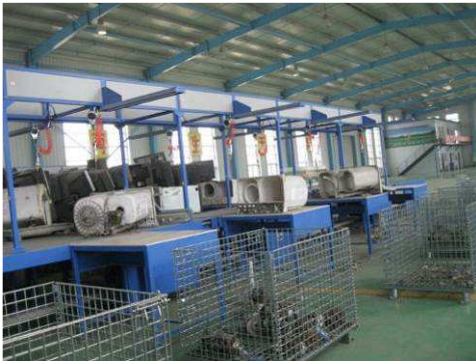
図 2. 1 2 家電解体ライン
