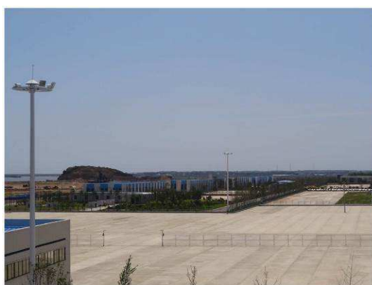
図 2. 7 園区内の建設施設
