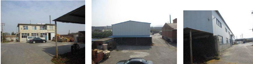
図2. 35 会社全景 事務所と工場
