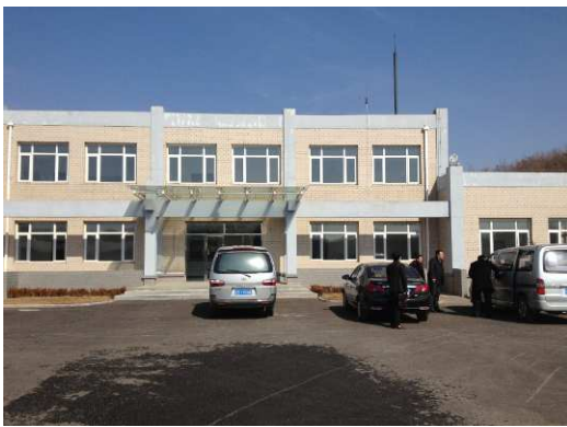
図2. 16 埋立処分場管理棟
