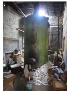
図 2. 3 4 暖房用ボイラー
