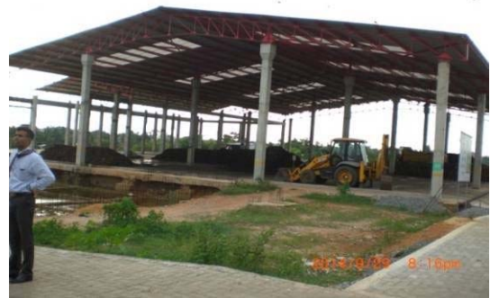
堆肥パイロット試験場
