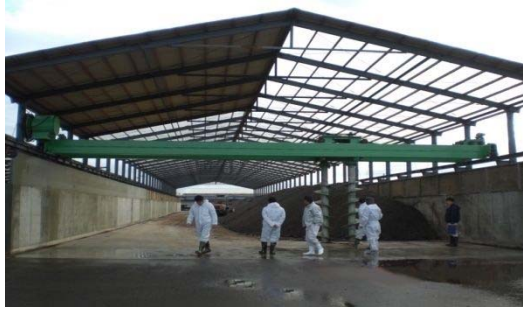
堆肥化施設全景
