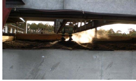
堆肥攪拌機稼働状況
