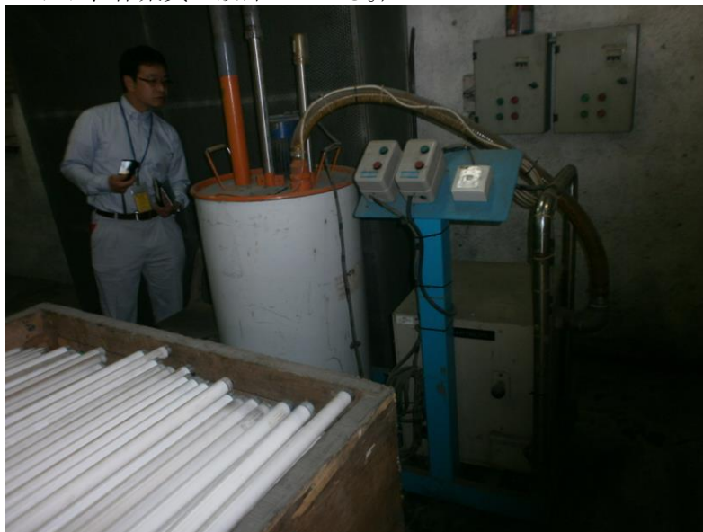
図：Victory Recovery 社（マラッカ州）の廃蛍光灯類の破砕処理設備（同社社長が自ら製作した破砕機、CFL は処理しておらず、蛍光管のみの処理である。）
