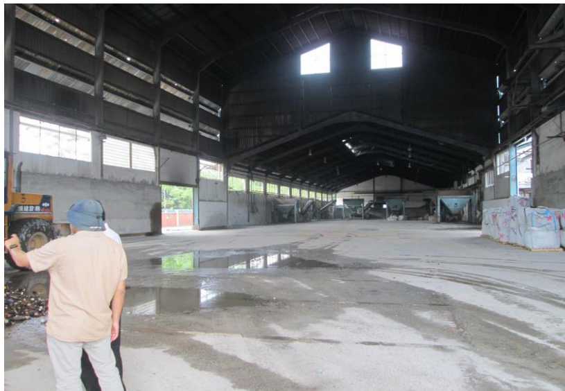
図：PUM 社ガラス倉庫内 (PUM 社は回収されたガラスビンやガラスメーカーからの不良品を受入れ・買取り、分別、洗浄、破碎などを行い、客先のニーズに応じた規格化を行うガラス問屋である。)
