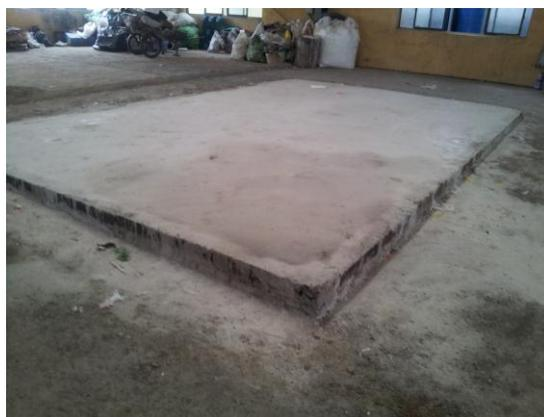
造粒機設置面の平坦化
