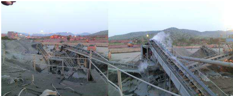
Photo.53-7 現状のスラグ処理工場(MRP-2)設備全景
