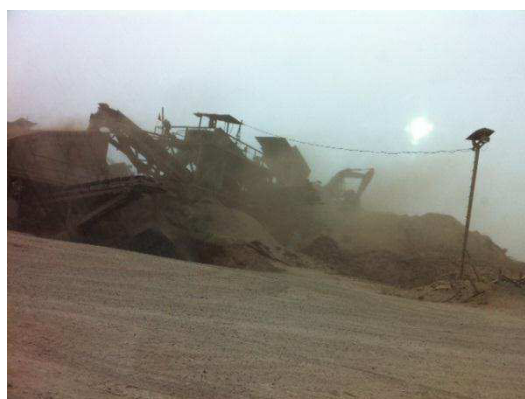
Photo.7-1 新規導入設備(環境対策なし)
