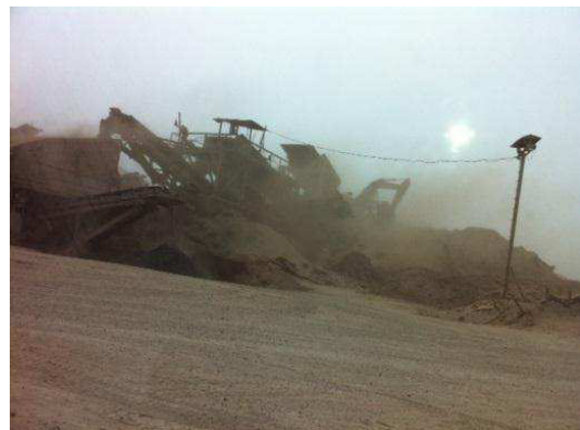
Photo.51-8 新規導入設備
