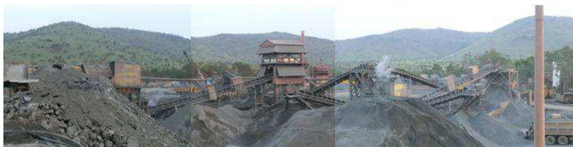
Photo.53-6 現状のスラグ処理工場(MRP-1)設備全景
