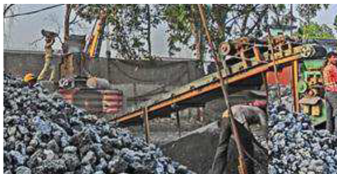
Photo.52-1 G2 社スラグ処理設備
