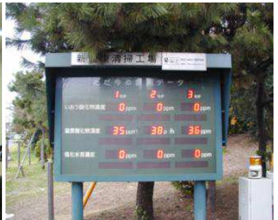
写真 5-10-51 排ガス測定表示板
