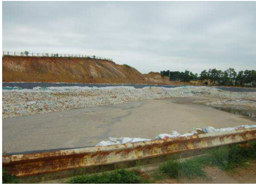
写真 5-10-38 Nam Son 埋立処分地第一期に残された最後の埋立区画
