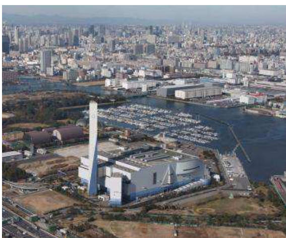
写真 5-10-12 新江東清掃工場
