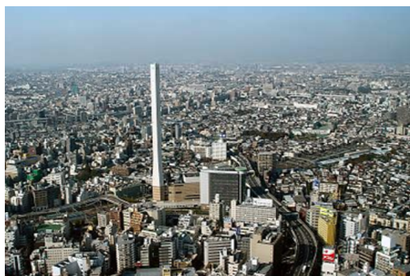
写真 5-10-5 大都会の中に建つ豊島清掃工場
