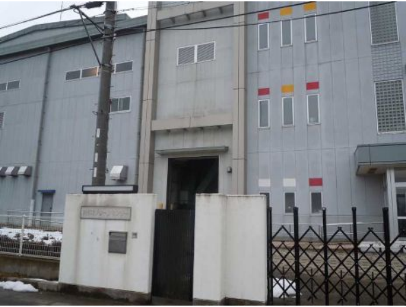
図表 34 綾部市クリーンセンター（綾部市野田町須知山 110 - 10）
