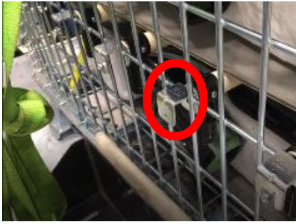
図 3-26 イレクターパイプに加工されたフック のネジが脱落
