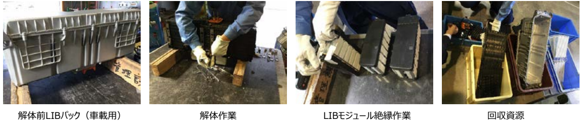
図 1.1-6 本実証事業における使用済 LIB の分解・手解体
