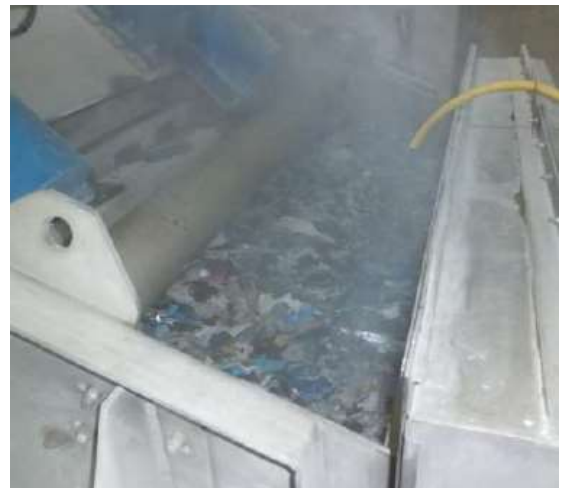
図 3-27 粉砕機への投入の様子
