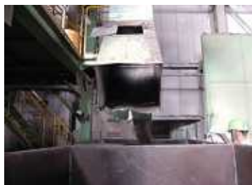
固化用 ASR 排出口
