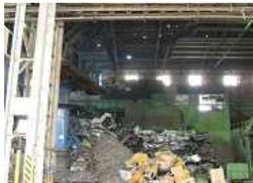
処理対象物投入状況
