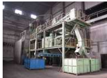
軽質 ASR 及び固化用 ASR 排出装置
