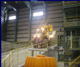
焼却灰の投入
