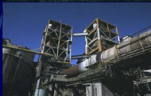
ロータリーキルン(焼成装置)とサスペンションプレヒーター(予熱装置)
