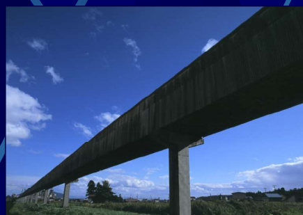
鉱山と工場を結ぶ6.2kmの原料輸送ベルトコンベア
