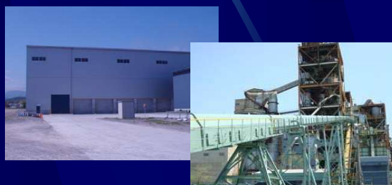
都市ごみ焼却灰処理設備(左)と窯灰投入設備(右)
