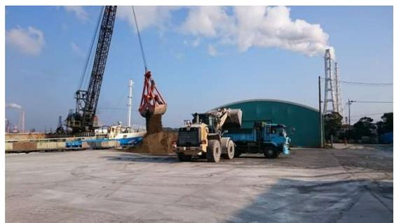
写真4 建設汚泥処理土の横もち
