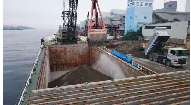
写真2 建設汚泥処理土の積込荷役
