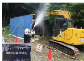
被災家屋等の解体の様子
