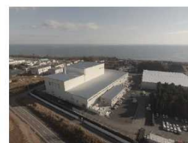
大熊町の仮設焼却施設
