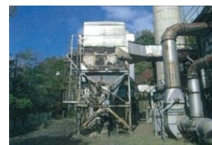
老朽化した廃棄物処理施設の更新
