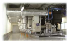
＜中央方式冷凍冷蔵機器＞
