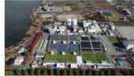
県有施設屋根貸し第1号 豊田終末処理場
