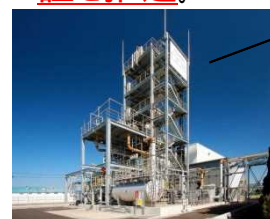
有害化学物質の放出を抑制可能な二酸化炭素分離回収設備
