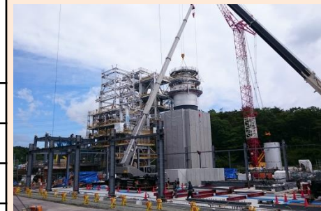
楢葉町の仮設焼却施設 (平成28年6月)
