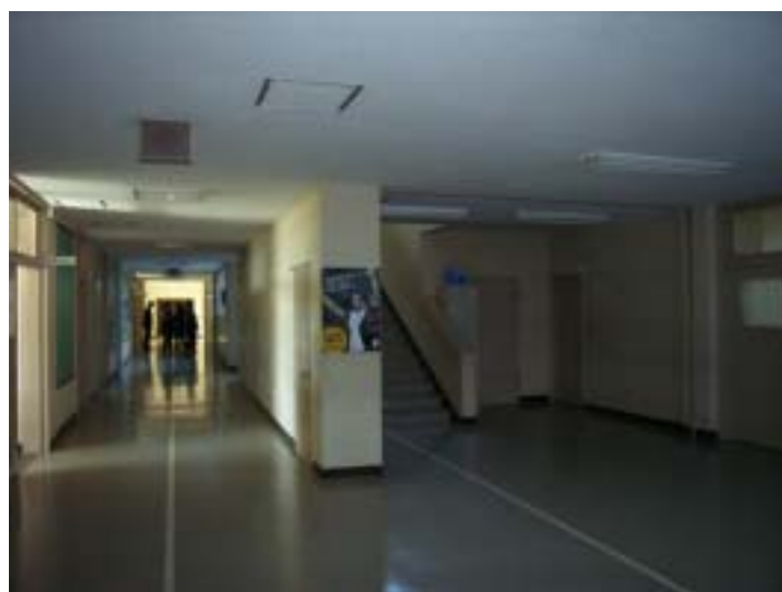
改修前：暗く、寒い廊下
