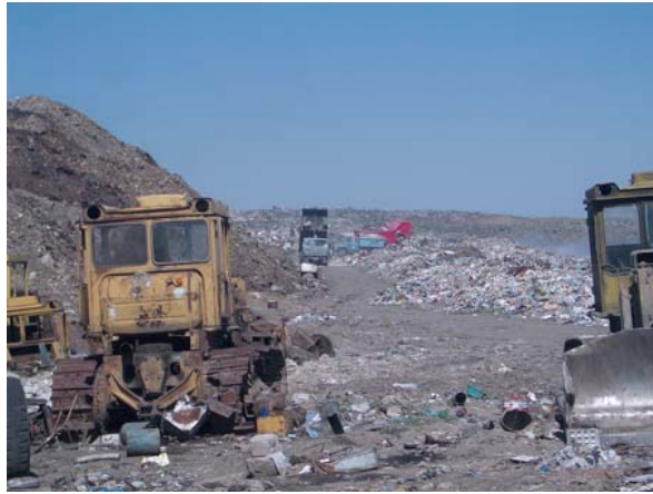
ヌバラシェン廃棄物埋立処分場
