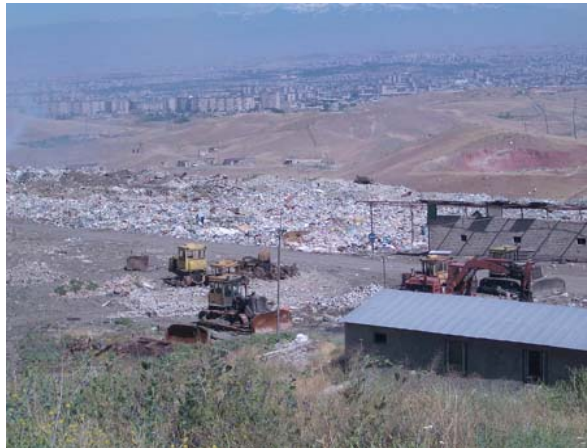
ヌバラシェン廃棄物埋立処分場
