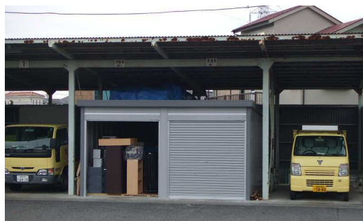
<新設したストックヤード>
