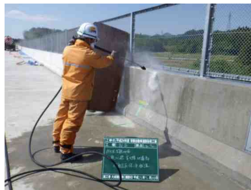
橋梁の洗浄作業
