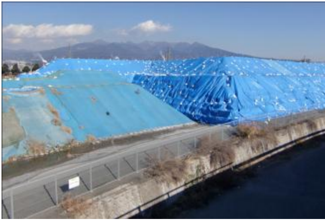
写真 16．ブルーシートの例 (撮影：渡辺修治)
