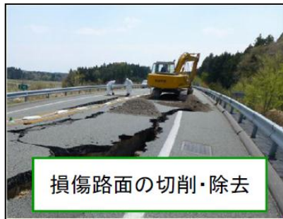
復旧工事で 発生する 建設副産物
