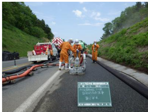
路面の高圧水洗浄
