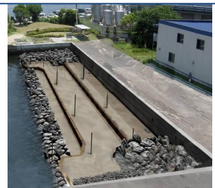
生物共生型護岸の整備
