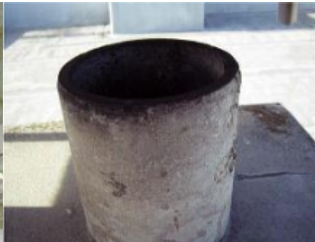
煙突用石綿断熱材 （レベル2）
