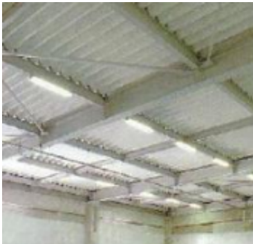
屋根用折板石綿断熱材 （レベル2）
