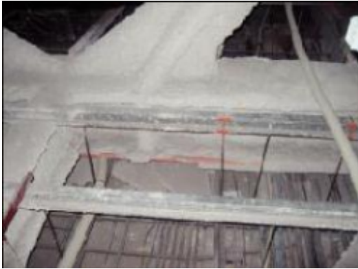
鉄骨耐火被覆材（レベル1）
