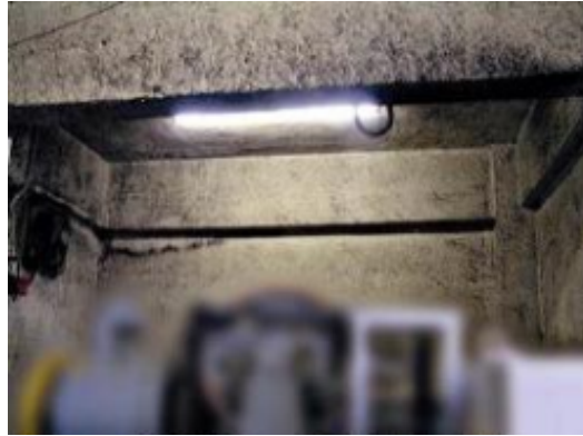
機械室吸音材（レベル1）
