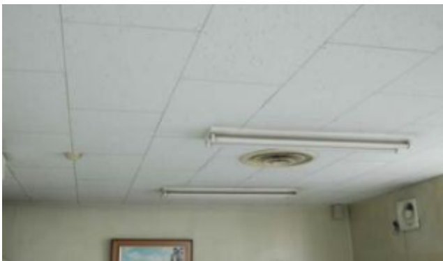
石綿含有ロックウール吸音天井板（レベル3）
