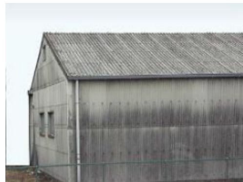
石綿含有スレート波板（レベル3）
