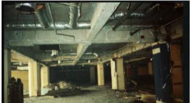
鉄骨耐火被覆（レベル2）
