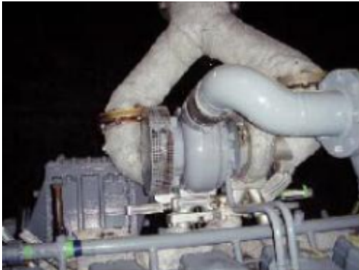
配管エルボ部分の保温材（レベル2）
