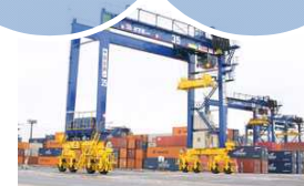
トランスファークレーン
