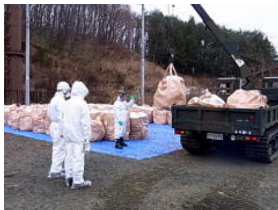
廃棄物の現場保管
