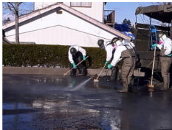
舗装面のブラッシング
