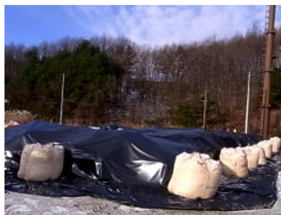
防水シート養生後
