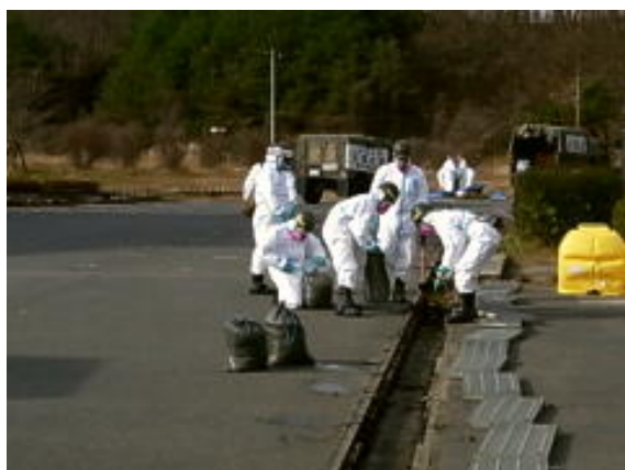
側溝の泥／落葉除去洗浄作業
