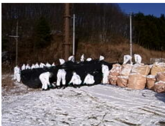
防水シート養生作業
