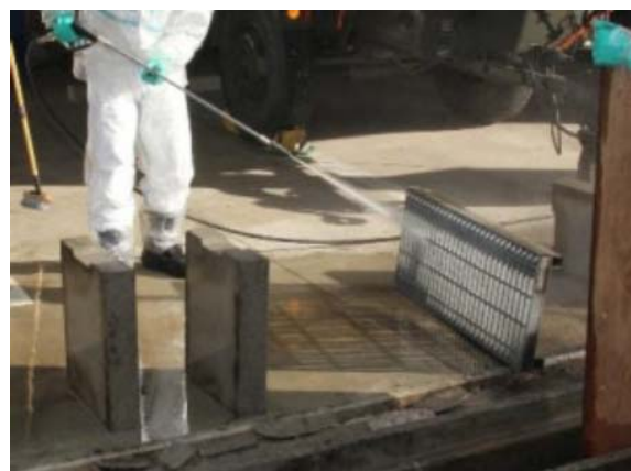
側溝内／蓋の高圧水洗浄
