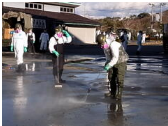
舗装面の高圧水洗浄
