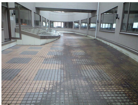
除染前の屋上
