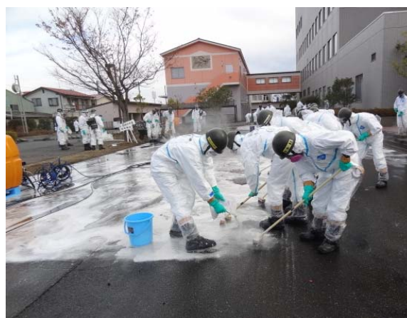
アスファルト部のブラシ作業 (クレンザー使用)
