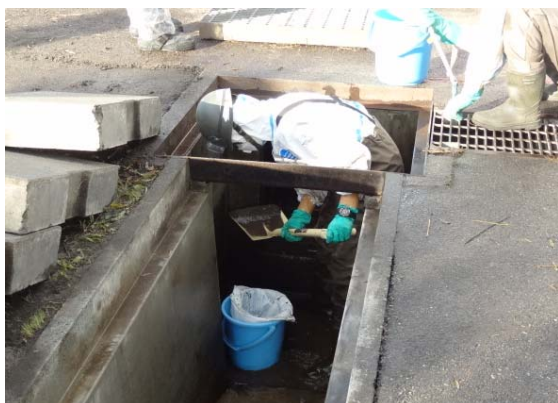
側溝の泥の撤去作業
