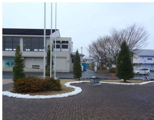
土嚢による境界部の養生の状況
