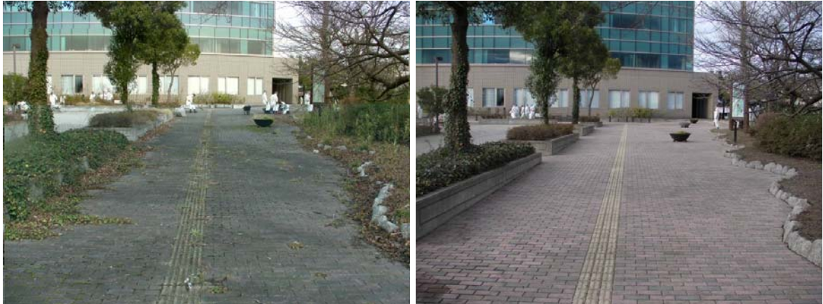
除染前後のインターロッキングブロック舗装面（左：除染前、右：除染後）
