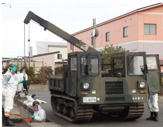
側溝の蓋はずし作業
