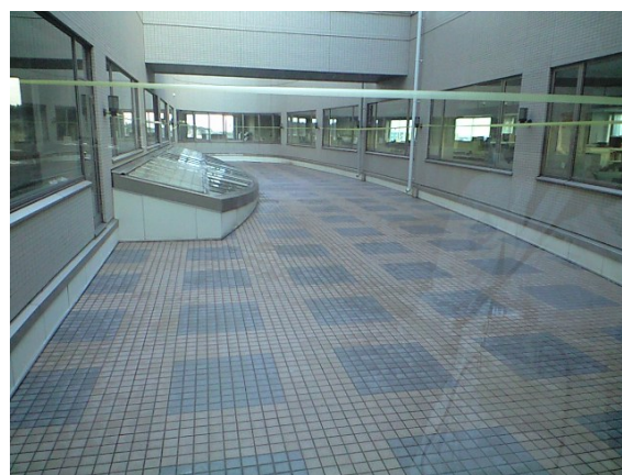
除染後の屋上
