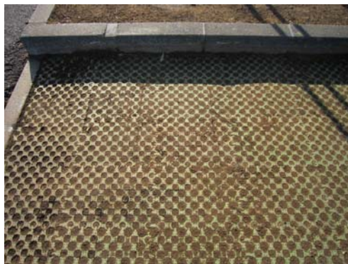
芝・土壌除去後の駐車場路面
