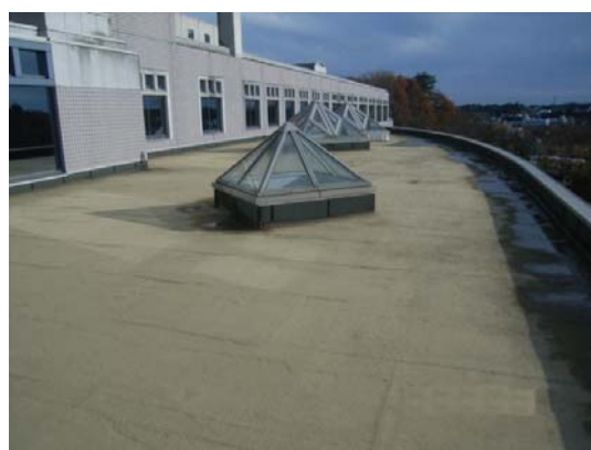
除染後の屋上
