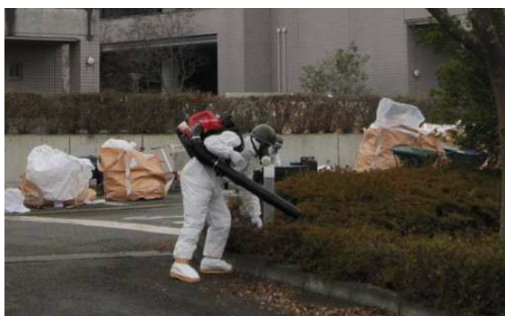
ブロアによる枯葉除去作業
