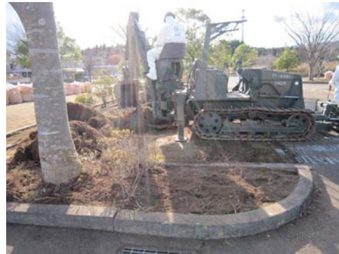
重機による表土除去作業
