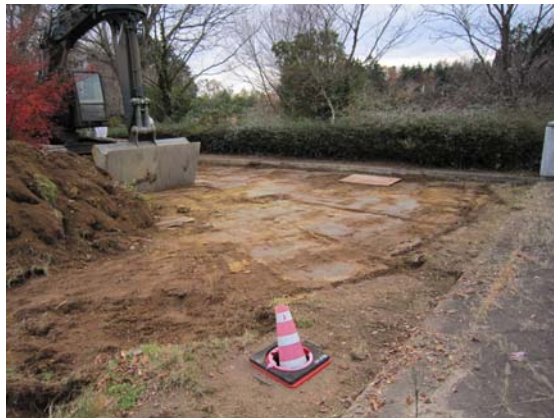
重機による芝・表土除去作業
