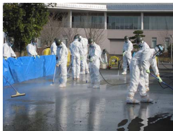
高圧水洗浄作業
