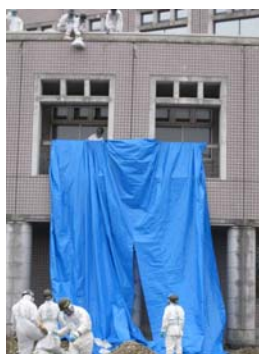
2階屋上の砂利の地上への搬出（左：ロープ、右：ブルーシート）
