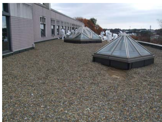
除染前の屋上(砂利敷き)
