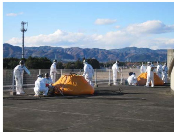
高圧水洗浄用の水タンク設置作業(庁舎屋上)
