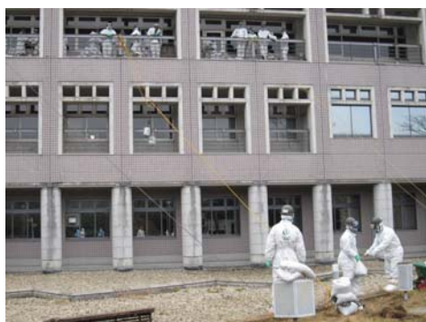
2階屋上の砂利の地上への搬出（左：ロープ、右：ブルーシート）
