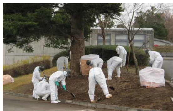
草刈り・表土除去作業
