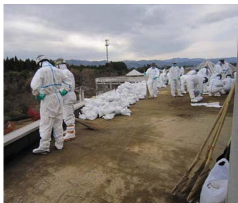
砂利除去作業（庁舎2F屋上）
