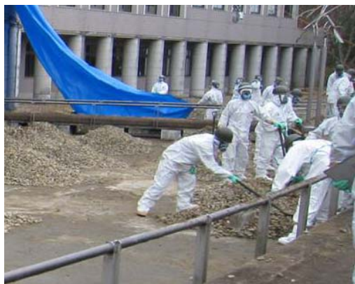
砂利除去作業（庁舎横）
