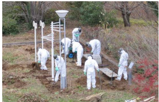
人手による芝・表土除去作業
