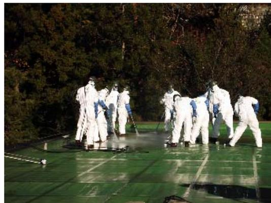
東庁舎屋上のブラッシング作業、高圧水洗浄作業
