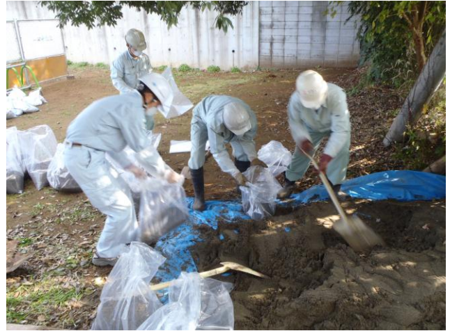
被覆砂の撤去作業
