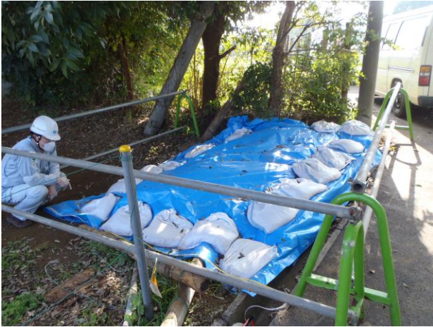
高線量箇所（シート等の撤去前）
