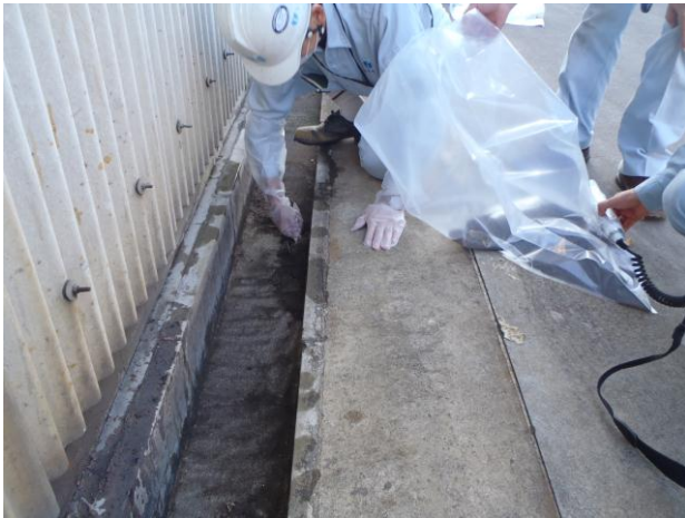
側溝での土壌の撤去作業
