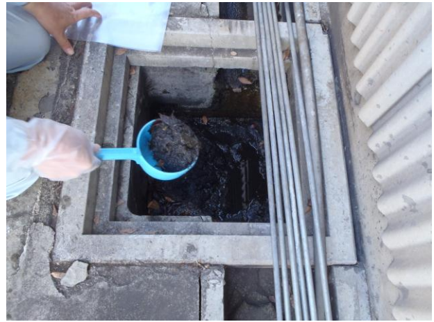
雨水枡での土壌の撤去作業
