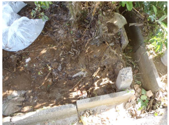
側溝破損箇所
