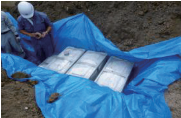
図-4-5：現場保管（地下保管）例
