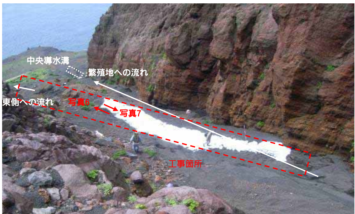
写真5: 工事実施箇所全景 (2011年5月実施後)
