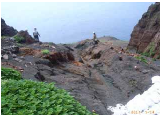
写真6 東側ルートへ繋げる尾根掘削箇所
