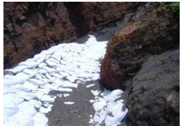
写真7 上部斜面の盛り土と土のう設置
