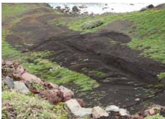
写真3: 掘削した中央導水溝 (2010年6月)
