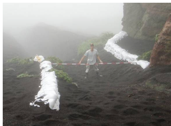
溝の上部に設置した土嚢壁（6月） 【写真は（財）山階鳥類研究所提供】
