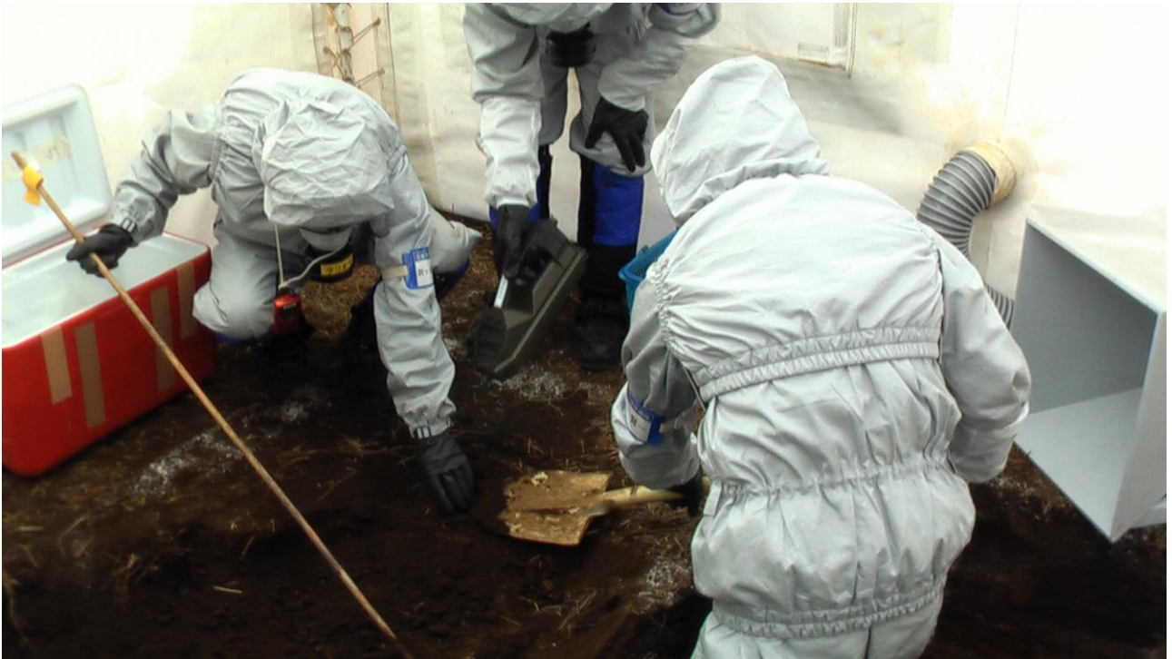
↑上：毒ガス用の防護服を着た作業員 ガス検知器を使いながら、掘削を行っ ている。
