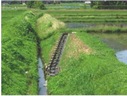
写真5. コウノトリの野生復帰の推進に向けた農地整備 水田に設置された魚道（写真提供：兵庫県但馬県民局地域振興部豊岡土地改良事務所）
