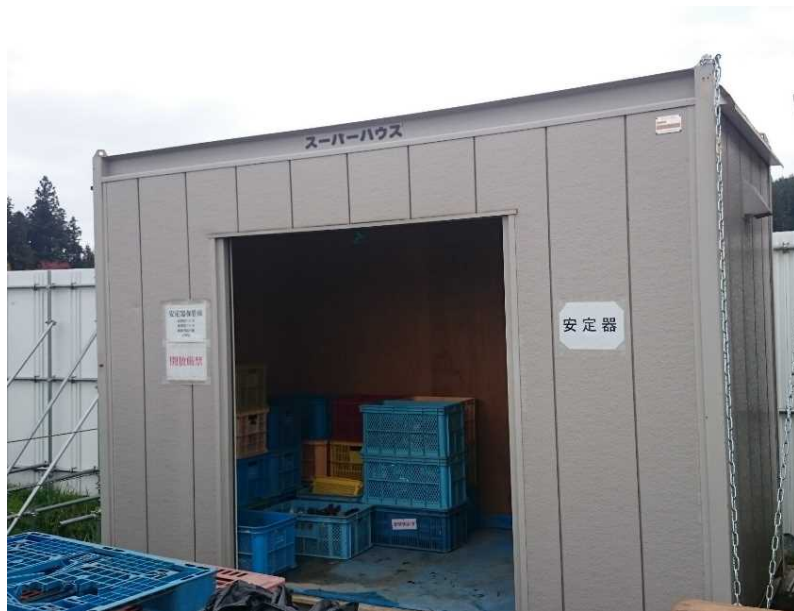
仮置場内のプレハブ倉庫
