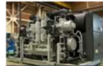
高効率冷凍機
