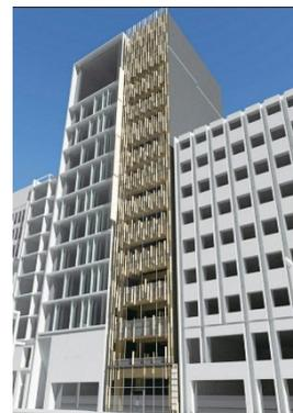
当ビルは、国産材等を使用した木造と鉄骨造とを組み合わせたハイブリッド構造である。木材は使用部位により調達先が異なっており、木材使用量全体に対して95%を占める
