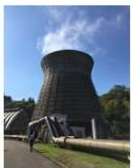
▲松川地熱発電所
