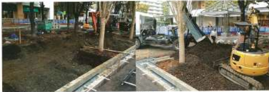
写真2-9 施工写真2 雨水貯留装置の基礎工事
