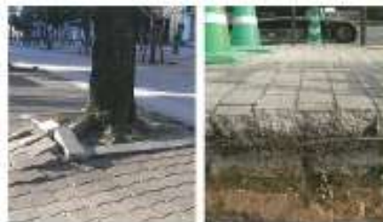
写真2-14、2-15 根上がり現象とその原因 根が表面仕上げ材が厚いと、根は地表面に近い層に伸び、やがて根上りを起こす。根上りによる歩道陥没事故に防ぐためにも、対策が必要。
