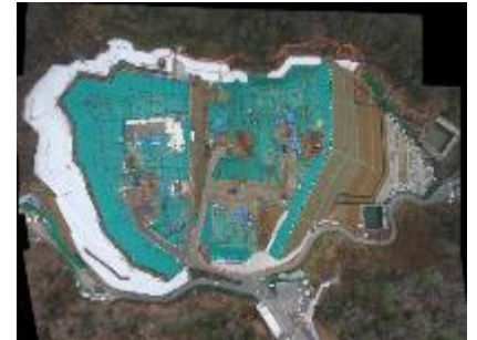
特定廃棄物埋立処分施設の様子
