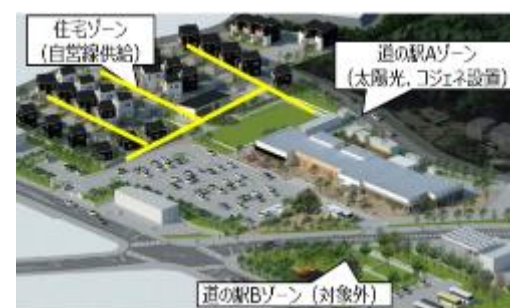
令和元年房総半島台風の際にエネルギー供給を行えた、むつざわスマートウェルネスタウン
