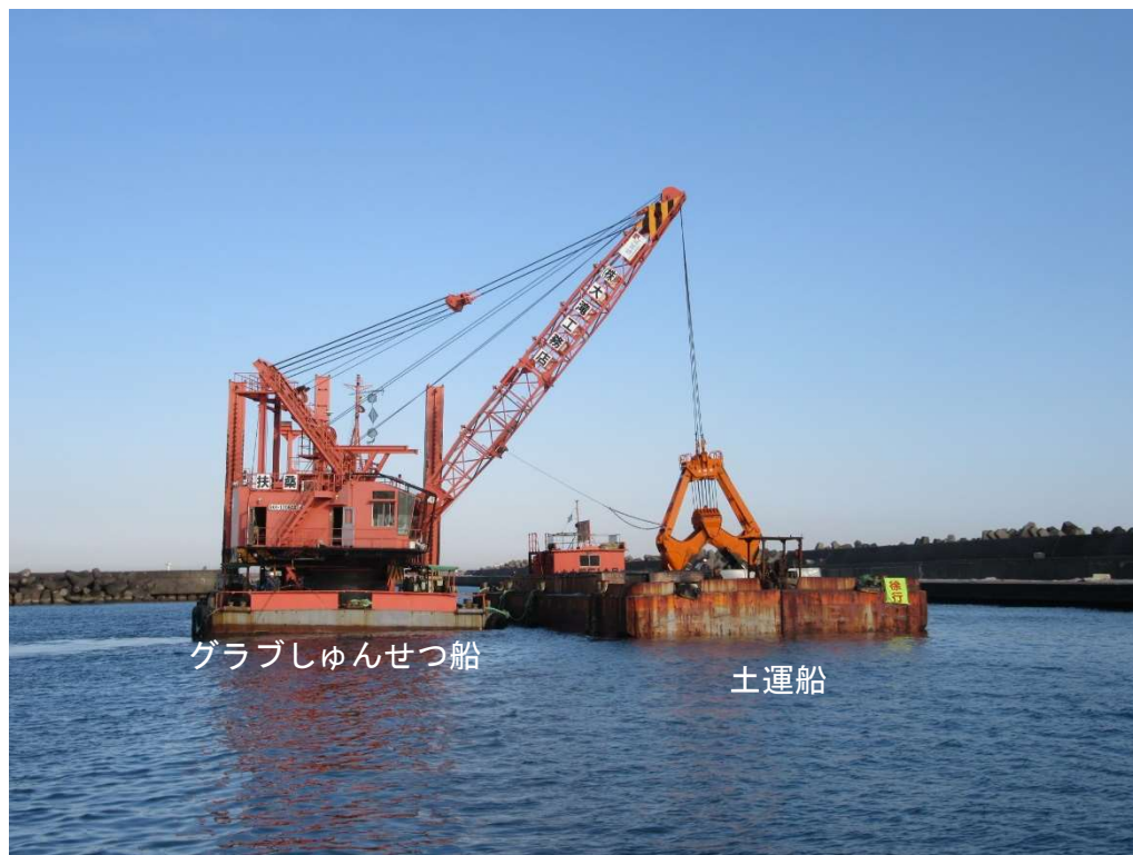
図 1 しゅんせつ作業状況 (例)
