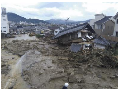
平成30年7月豪雨の被害の様子
